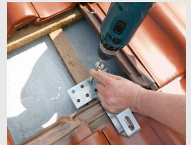
Solarhalter mit Schrauben an Konterlattung befestigen.
