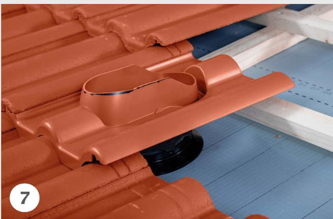
**7** Positionierung und Eindeckung der Grundplatte über den schon im Unterdach eingebauten Unterdachanschlussadapter, oder der EPDM-Manschette.
