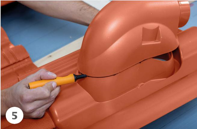
**5** Aufsetzen des Solardurchgangs bis zu den angezeichneten Höhenlinien und umfahren der Kontur für den späteren Trennschnitt.
