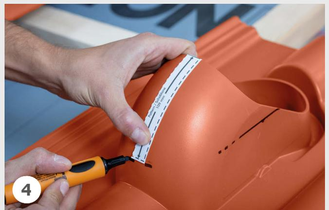
Anhalten der Schablone gemäß der Markierung und anzeichnen der Höhenlage für den späteren Trennschnitt.
