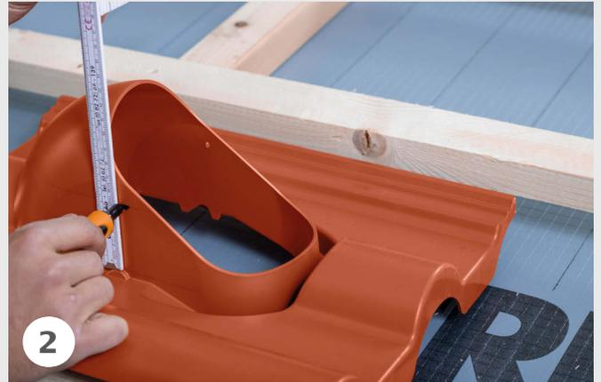
Anzeichnen einer Hilfslinie mit einem Abstand von 5 cm zum späteren Abtrennen der Kappe.
