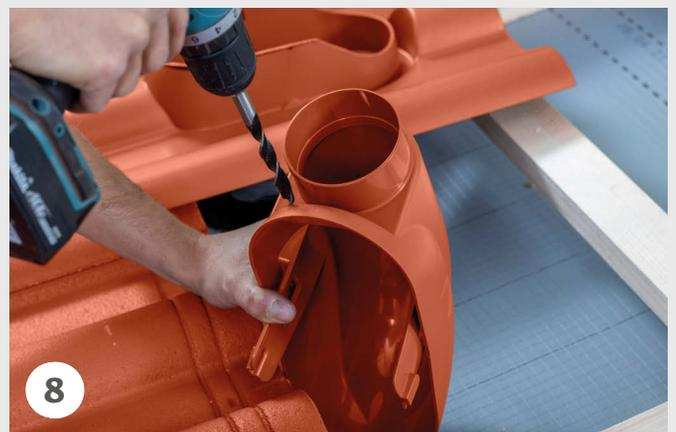
**8** Bohrung mittels Holzbohrer Durchmesser 10 mm für die Kabeldurchführung (z.B. Erdungskabel) anbringen.
