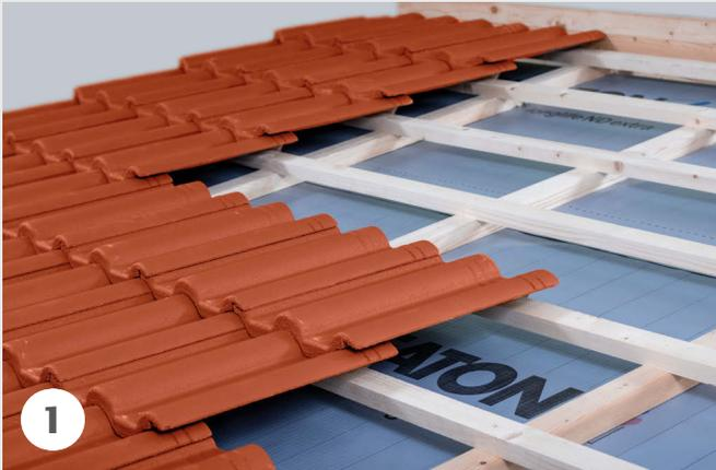
Das Dach mit einer Unterdachbahn und der Lattung vorbereiten, um mit den Dachsteinen bis zum eingebauten Unterdachanschlussadapter eindecken zu können. Zur besseren Darstellung wurde das Dach von links nach rechts eingedeckt.
