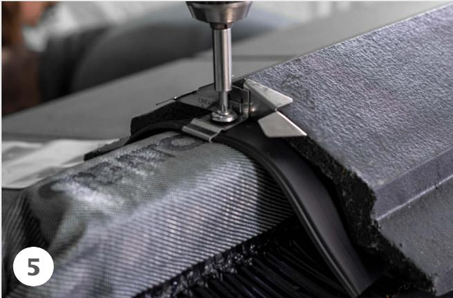
Alle Firststeine mit der First-/Gratklammer auflegen, zusammenschieben und anschrauben.
