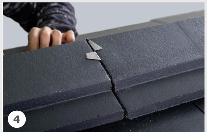
Positionierung des anschließenden Firststeins.
