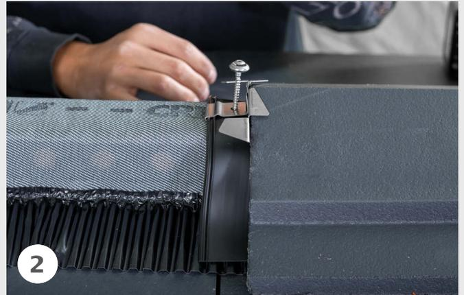
Anschrauben des ersten Firststeins und einschieben der First-/Gratklammer.
