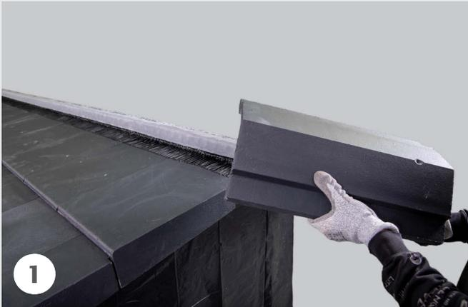
Nach der Eindeckung und der Vorbereitung mit der CREAROLL First- und Gratrolle wird der erste Firststein mit Firstanfangsscheibe positioniert. Die Befestigung erfolgt mit einer speziell entwickelten First-/Gratklammer auf der hochkant verlegten First-/Gratlatten 30/50 mm. Werden breitere First-/Gratlatten verwendet, kann es erforderlich werden, die First-/Gratklammer zu unterlegen, um ein Kippen zu verhindern. Weiterhin muss eine ausreichende Belüftungsöffnung vorhanden bleiben.
