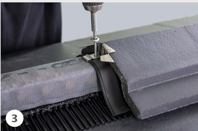
Anschrauben der First-/Gratklammer KAPSTADT an die Firstlatte mit den dafür in der Verpackung enthaltenen Schrauben.
