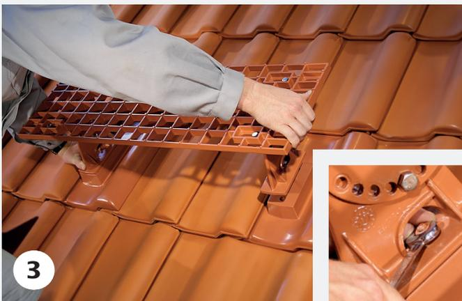
Der Langrost wird in die Vorrichtungen der Alu-Grundelemente eingesetzt und mit den mitgelieferten Schrauben samt Sprengringen befestigt.
