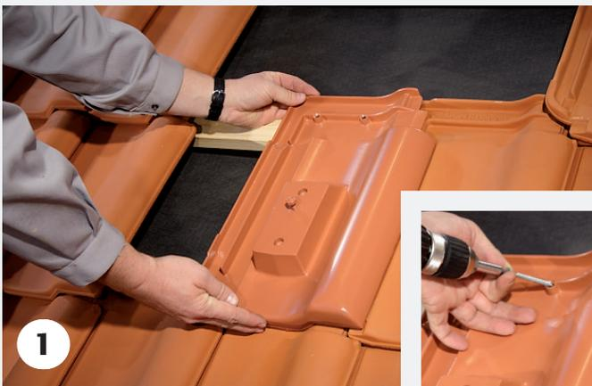
Das Alu-Grundelement wird in die Fläche eingedeckt und mit den zwei korrosionsbeständigen Schrauben an der Traglattung befestigt. Die zusätzliche Montage einer Stützlatte ist nicht erforderlich.
