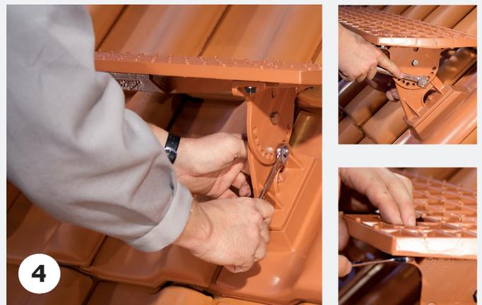
Die Schrauben am Drehkranz werden entfernt, so dass der Langrost auf die vorgegebene Dachneigung eingestellt werden kann. Danach wird der Drehkranz wieder befestigt. Hierzu wird ein 13er Schraubenschlüssel verwendet.
