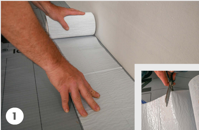
1 Unterdachanschlussband UAB ausrollen und auf Länge abschneiden.
