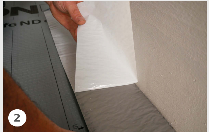
2 Unterdachanschlussband UAB mittig falten und Folie abziehen.
