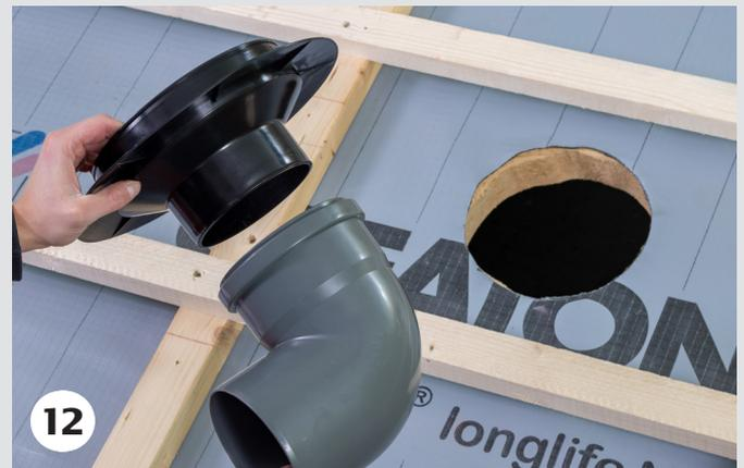
**⚠ Alternativ:** kann ein HTsafe-Rohr(bogen) direkt an dem Grundträger D angeschlossen werden. Montageschritte zum Einbau identisch zum Flex-Schlauch.
