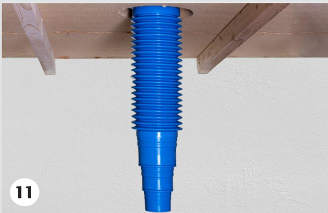
Darstellung lotrecher Einbau im Dachraum. Bei einer Umlenkung ist darauf zu achten, dass die Rohr- und Schlauchweiterführung vom Dunstrohr gemäß DIN 1986-100 und dem ZVDH-Regelwerk mit einem Gefälle einzubauen sind.
