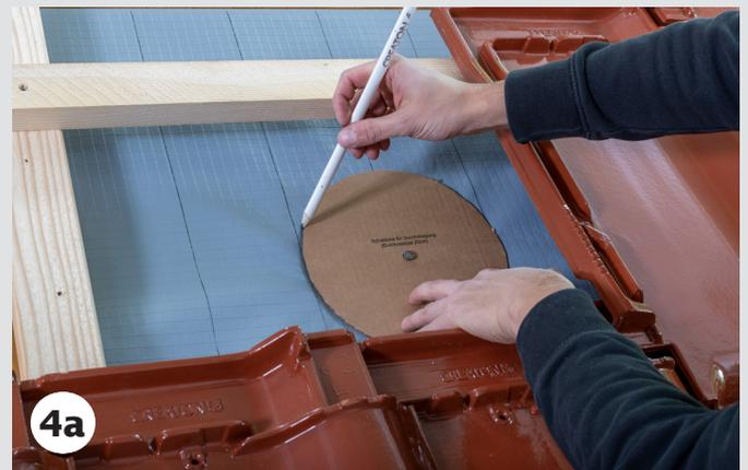
Anschließend die Schablone im 90° Winkel zur Dachfläche an den rechts eingedeckten Ziegel anlegen und in der darüber positionierten Traglatte einhängen.
