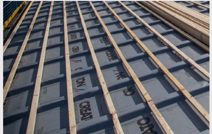
Die 7°-Sonderlösung – wasserdichte Unterdach in finaler Ausführung. Weitere Informationen unter www.creaton.de .
