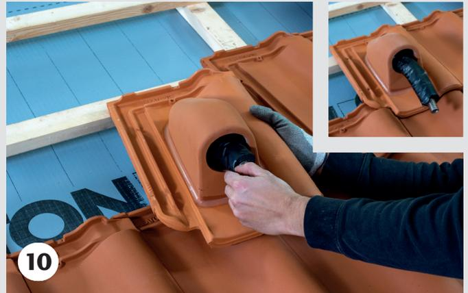
Die Solarleitung durch den Solar-Durchgangsziegel ziehen und den Funktionsziegel eindecken.
