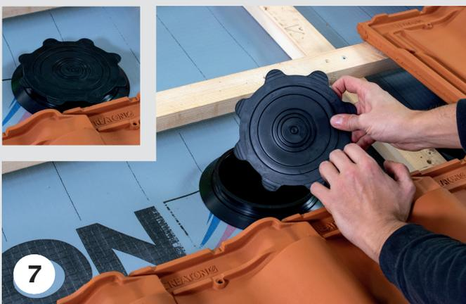
Die EPDM-Manschette mittels der unterseitigen Gummilippe am Klickring befestigen.
