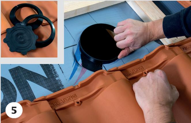
Den Adapter vorbereiten und das Unterteil/den Grundträger des Unterdachanschlussadapters in die Unterdachbahn ein-drehen. Dachbahn in die Kerbe am Ring einführen und im Uhrzeigersinn komplett eindrehen.
