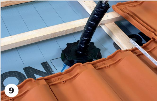
Die Solarleitung durch die EPDM-Manschette führen.
