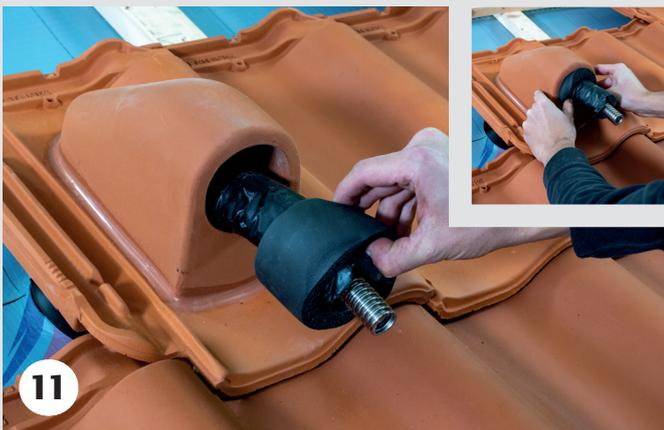
Anschließend den Dichtungsring über die Solarleitung in den Solar-Durchgangsziegel einschieben und auf dichten Sitz prüfen.
