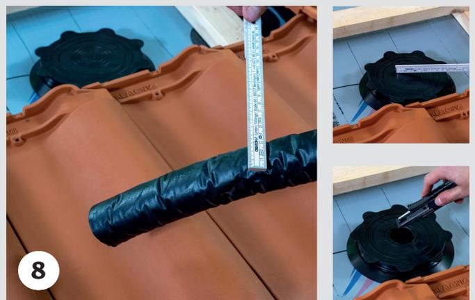
Den Durchmesser der Solarleitung auf der EPDM-Manschette übertragen und mittels Cuttermesser an der Perforierung das Material entnehmen.
