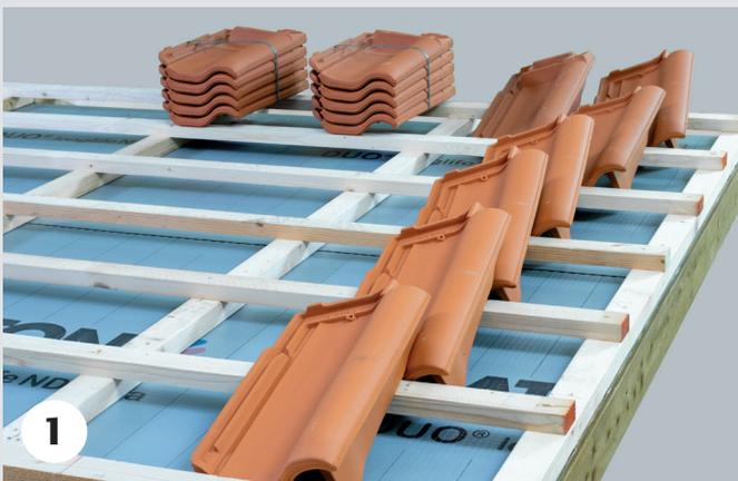
Zur Vorbereitung wird das Ortgangbrett oder die entsprechend baulichen Maßnahmen angebracht und die Ortgangziegel zum Eindecken auf der Lattung abgelegt.
