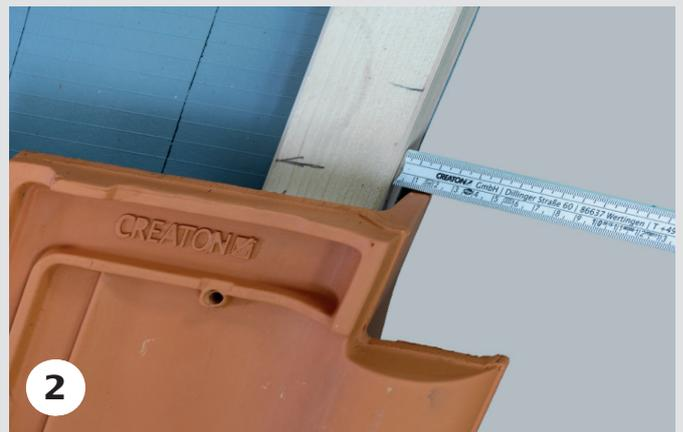
Gemäß ZVDH-Regelwerk soll bei Ortgangziegeln der Abstand zwischen Innenkante Ortganglappen und Außenkante Giebelwand oder Ortgangbrett/Bekleidung mindestens 1 cm betragen.
