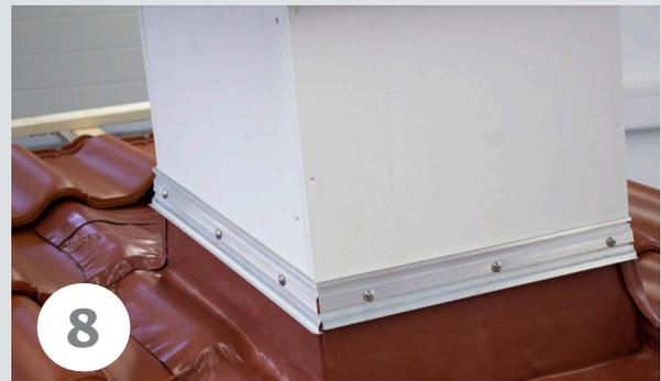
Nach dem Anbringen aller Schienen werden diese mit dafür geeigneter Klebe- und Dichtmasse oberseitig abgedichtet.
