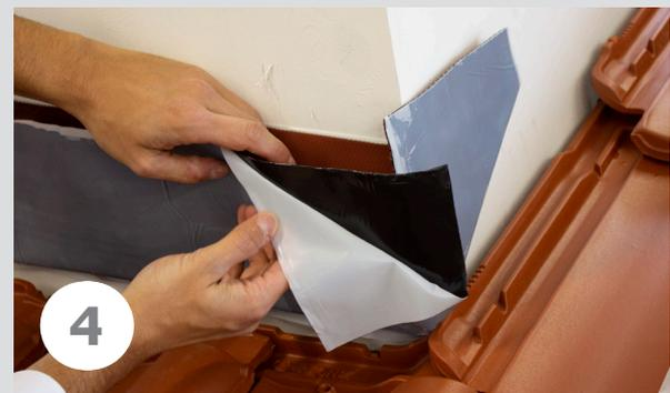
Nach dem Entfernen der geteilten Abziehfolie kann gemäß der Profilierung des Bedachungsmaterials das Band angepasst werden. Durch leichtes Andrücken wird eine kraftschlüssige Verbindung erzielt. Bitte beachten Sie hierbei die Verarbeitungstemperatur von min +5°C.
