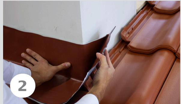
An den Kaminecken falten Sie die Enden des Anschlussstückes aufrecht zur Kaminseite an. Hierdurch entsteht eine ununterbrochene Materialecke. Überlappung PIB traufseitig auf den Dachziegel oder Dachstein:
