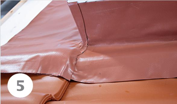
Ziehen Sie die rückseitige Schutzfolie ab und klappen Sie den Überstand um. Hier empfehlen wir Ihnen mit der Anpressrolle zu arbeiten, um eine kraftschlüssige Verbindung zu erzielen. Anschließend kann das CREAMFLEX PIB an das Dachdeckungsmaterial angeformt werden.
