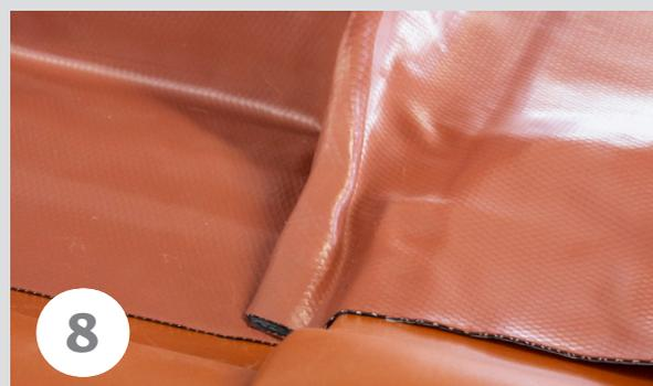
Am Firstseitigen Ende des Anschlusses schneiden Sie das Anschlussstück der zuvor erstellten Materialecke so zurecht, dass das firstseitige Anschlussstück an dieser Stelle um ca. 3 cm überlappt. Achten Sie beim Ankleben, dass Sie von der inneren Rundung nach außen vorgehen, um Lufteinschlüsse zu vermeiden. Hierbei empfiehlt sich eine Andrückrolle.
