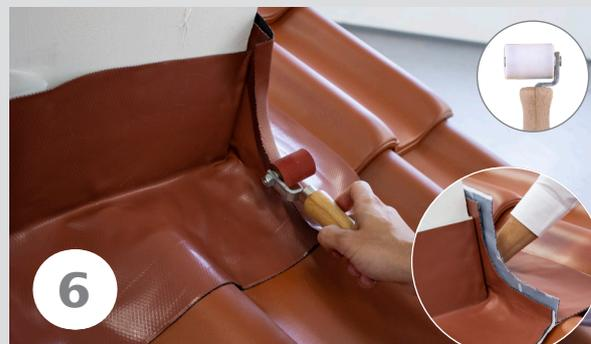
Schneiden Sie entlang der Kaminfront und der wasserführenden Fläche des Bedachungsmaterials mit einem Abstand von ca. 3 cm. Die beiden Schnittlinien werden an ihrem Treffpunkt mit einer gleichmäßigen Rundung zusammengeführt. Danach kann bereits die rückseitige Schutzfolie abgezogen werden und das CREFLEX PIB an das Dachdeckungsmaterial angeformt werden.
