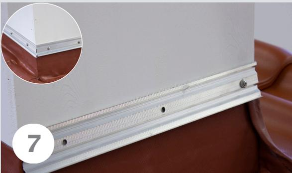
Den Kaminabschluss bilden dafür geeignete Anpressschienen. Diese werden entsprechend Kaminbreite/-tiefe und Dachneigung angepasst. Die Befestigung erfolgt mit passenden Befestigungsmaterial. Dabei ist darauf zu achten, dass die Schrauben korrosionsbeständig und mit einer Dichtscheibe versehen ist.
