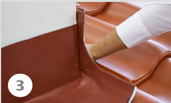
Schneiden Sie seitlich entlang der Kaminfront und der wasserführenden Fläche des Bedachungsmaterials mit einem Abstand von ca. 3 cm, sodass eine Rundung entsteht. Das Material lässt sich mit einer Schere oder einem Cuttermesser einfach zurechtschneiden.
