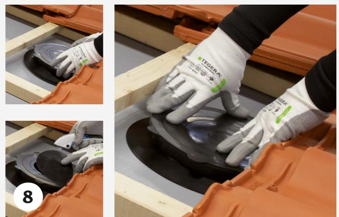
Der obere Ring kann sowohl mit der Gummimanschette, als auch ohne aufgesetzt werden. Die Gummimanschette muss dann nachträglich eingeklemmt werden.
