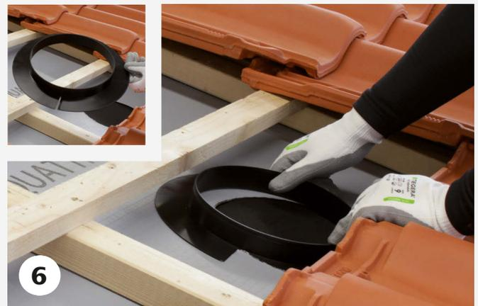
Der Unterdachanschlussadapter besteht aus 3 einzelnen Teilen (Grundträger, Dichtring, Gummimanschette) und ist für alle handelsüblichen Unterdachbahnen verwendbar. Beim Einsatz von Holzweichfaserplatten muss ein passender Unterdachbahnenflansch (ca. 0,50 x 0,50 m) mit Hilfe der Schablone ausgeschnitten und aufgeklebt werden. Bitte beachten Sie die jeweiligen Herstellerangaben bzgl. der Vorbehandlung mit Primer-Grundierungen.
