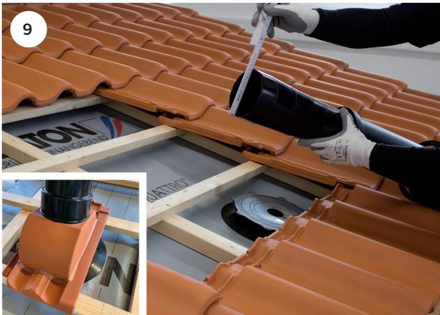
Der Durchmesser des Thermendrohres wird auf die Gummimanschette übertragen. Die Manschette wird, wenn möglich, an der vorgegebenen Rille herausgeschnitten. Das Thermrohr ist nicht im wienerberger Lieferumfang enthalten. Bitte wenden Sie sich an Ihren Heizungsbauer.
