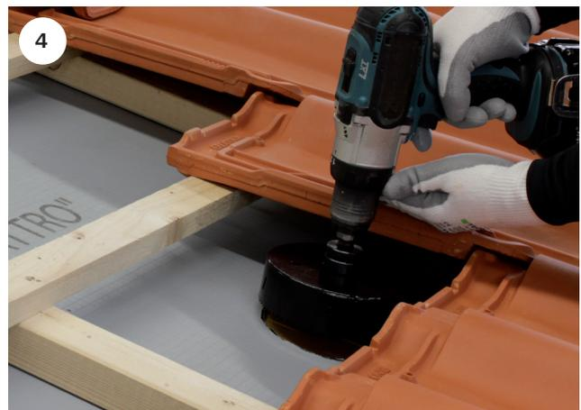
Je nach Dachaufbau muss die Holzschalung oder Aufdachdämmung mit einer Säge oder ähnlichem ausgeschnitten werden. Der Durchmesser der Bohrung entspricht der jeweiligen Durchdringung + mindestens 1 cm.
