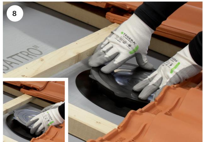
Der Dichtring wird mit ausreichendem Anpressdruck auf den Grundträger geklemmt bis dieser hörbar einrastet.
