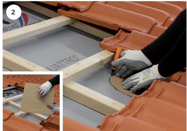
Der äußere Durchmesser der Schablone wird herausgetrennt. Die Schablone wird auf die Unterdachbahn an die richtige Position geklebt und der Durchmesser des Grundträgers auf die Unterdachbahn übertragen.
