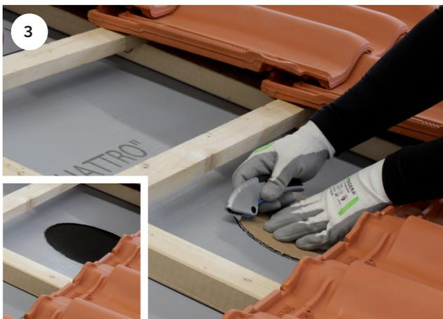
Die Unterdachbahn wird mit einem geeigneten Cuttermesser oder einer Schere an der gekennzeichneten Stelle herausgeschnitten.
