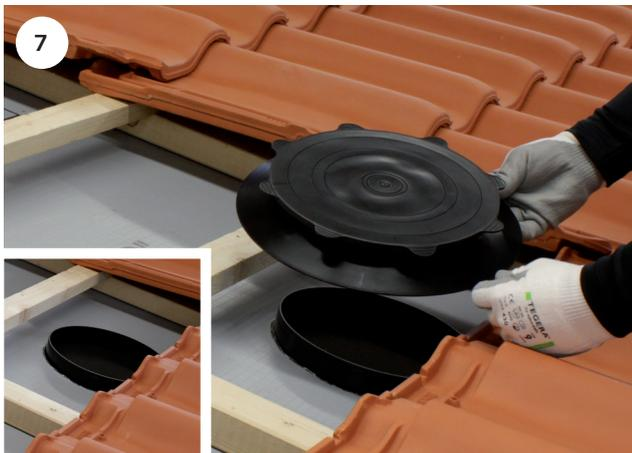
Der Dichtring kann sowohl mit der Gummimanschette, als auch ohne aufgesetzt werden. Die Gummimanschette muss dann nachträglich aufgezogen werden.
