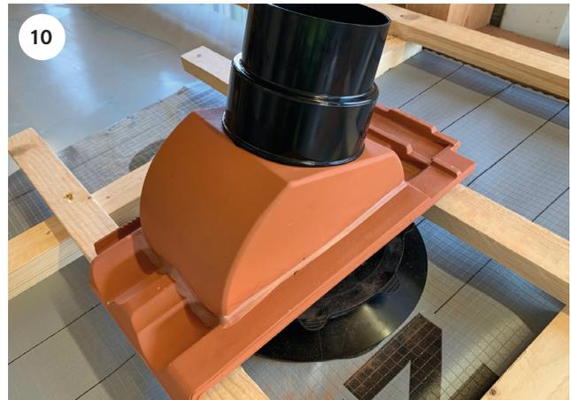
Der Thermendurchgangziegel wird in die Dachfläche eingedeckt. Das Thermrohr wird durch die Öffnung geführt und im Dachraum weiter verarbeitet.
