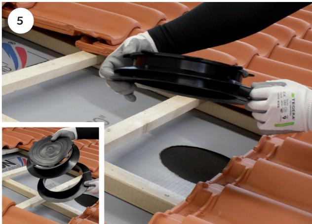
Der Unterdachanschlussadapter besteht aus drei einzelnen Teilen (Grundträger, Dichtring, Gummimanschette) und ist für alle handelsüblichen Unterdachbahnen verwendbar. Beim Einsatz von Holzweichfaserplatten muss ein passender Unterdachbahnenflansch (ca. 0,50 x 0,50 m) mit Hilfe der Schablone ausgeschnitten und aufgeklebt werden. Bitte beachten Sie die jeweiligen Herstellerangaben bezüglich der Vorbehandlung mit Primer-Grundierungen.
