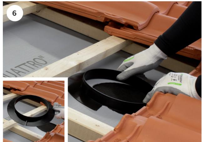
Der Grundträger wird in die Unterdachbahn im Uhrzeigersinn eindreht. Dazu wird die Kerbe am Ring in die Unterdachbahn eingeführt und der Ring komplett eingedreht.
