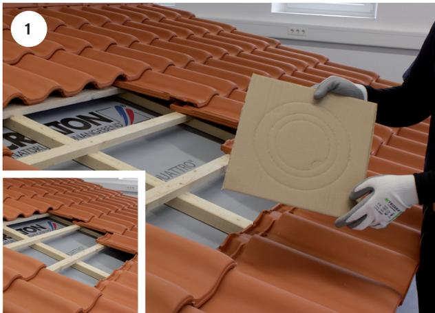
Die Position des Thermendurchgangziegels auf dem Dach festlegen und prüfen. Damit der richtige Durchmesser aus der vorhandenen Unterdachbahn herausgeschnitten werden kann, sollte die mitgelieferte Schablone verwendet werden.
