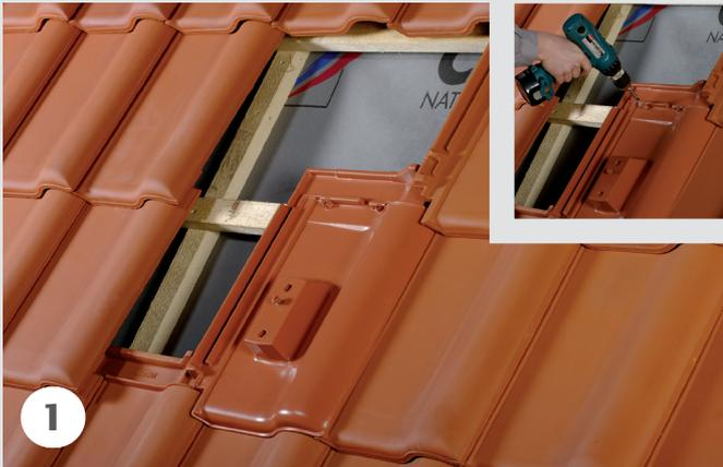
Das Aluminium-Grundelement wird in die Dachfläche eingedeckt und mit zwei korrosionsbeständigen Schrauben an der Traglattung befestigt. Die zusätzliche Montage einer Stützlatte ist nicht erforderlich.
