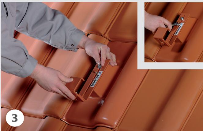
Die Schraube am Grundelement wird gelöst und der Dachleiterhalter passend aufgesetzt und befestigt. Die zusätzlich am Dachleiterhalter befestigte Schraube wird in der Lochung am Aluminium-Grundelement eingeführt. Somit wird ein Verrutschen des Halters verhindert.
