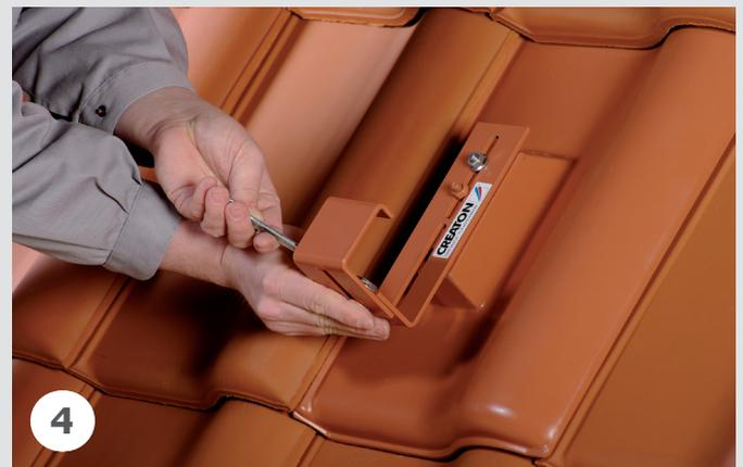
Der Haken zur Fixierung der Dachleiter wird gelöst. Hierzu wird ein 13er Schraubenschlüssel benötigt.
