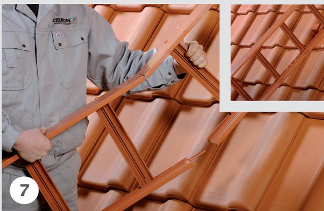
7 Für das Verbinden von zwei Dachleitern werden zwei Verbinder benötigt.
