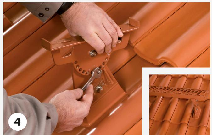
Die Schrauben am Drehkranz werden entfernt, so dass der Langrost auf die vorgegebene Dachneigung eingestellt werden kann. Danach wird der Drehkranz wieder befestigt.
