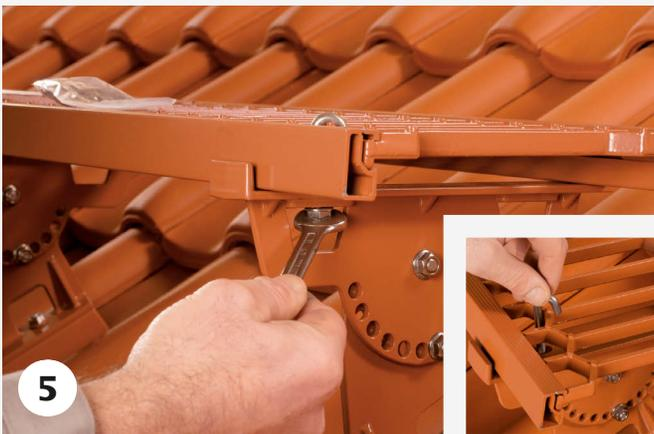
Der Laufrost wird mittels Rundhaken an den Rosthaltern befestigt. Pro Rosthalter müssen zwei Rundhaken verwendet werden.
