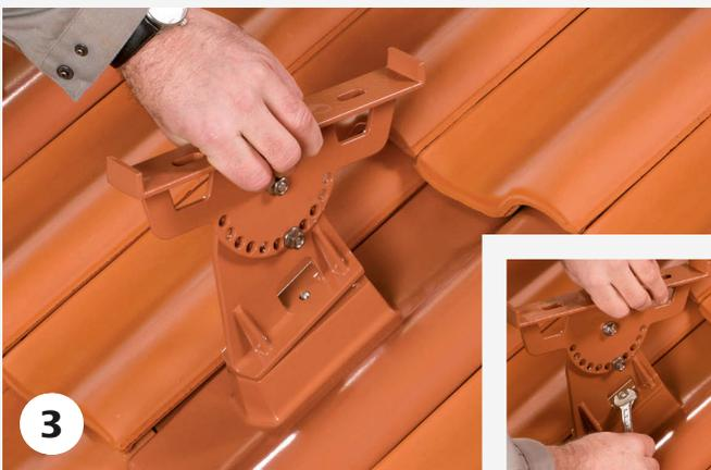
Die Rosthalter werden in die Vorrichtung der Alu-Grundelemente eingesetzt und mit der mitgelieferten Schraube befestigt.
