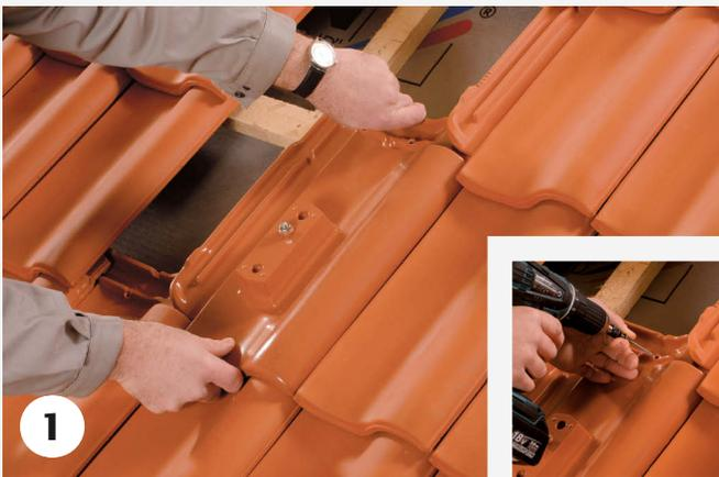
Das Alu-Grundelement wird in die Fläche eingedeckt und mit zwei korrosionsbeständigen Schrauben an der Traglattung befestigt. Die zusätzliche Montage einer Stützlatte ist nicht erforderlich.
