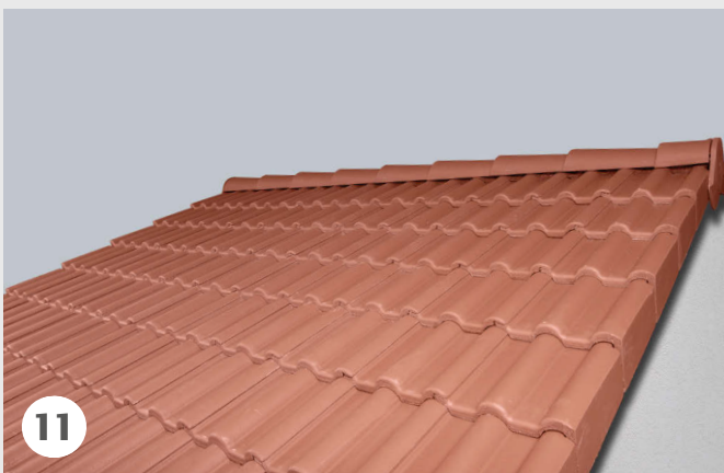
11 Fertigstellung der Firstausbildung mit Anbringung der Funktionsanfang- und -endscheiben.
