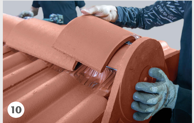
10 Einpassen des letzten Firststeins und einklemmen in beide Firstklammern.
